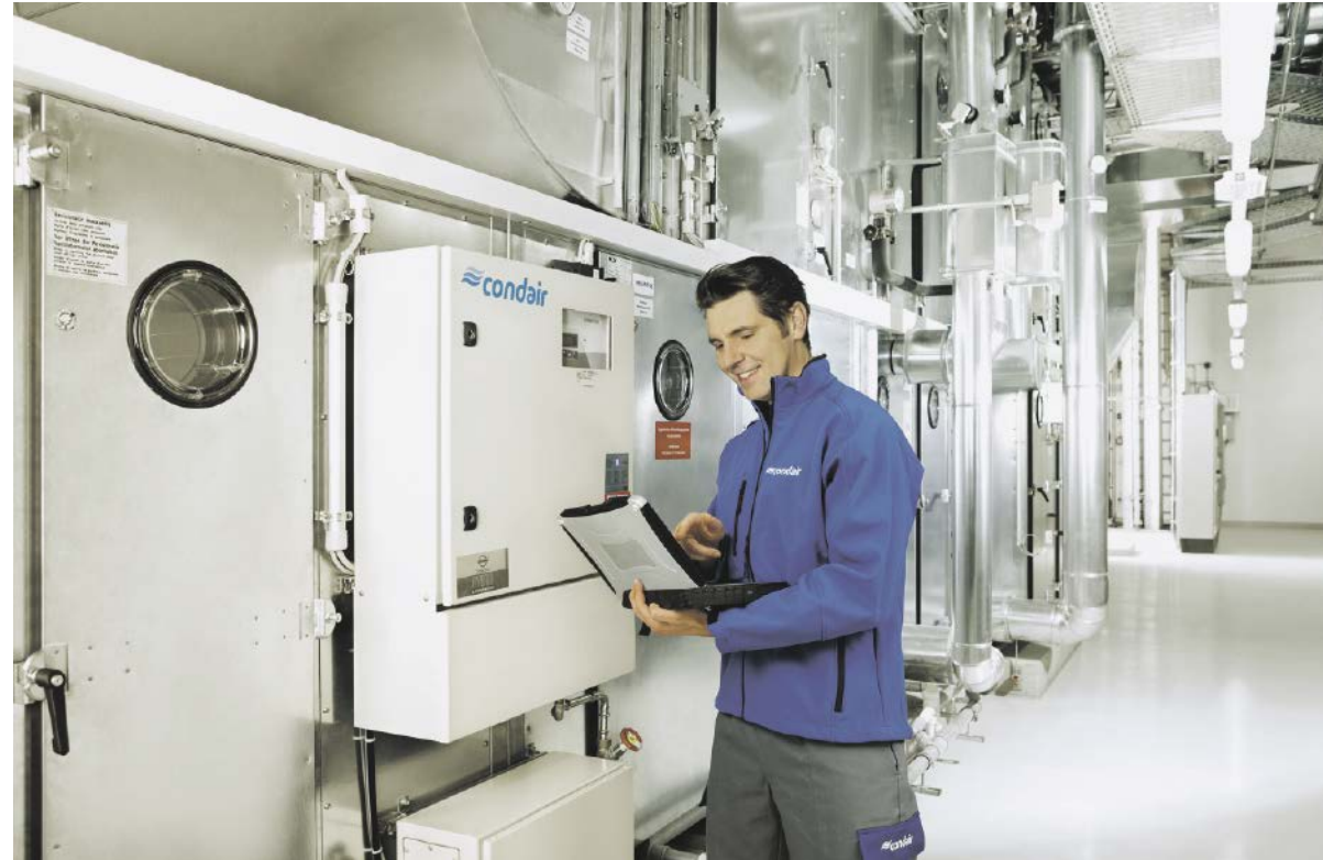
Ein Servicetechniker führt die energetische Inspektion durch und prüft die Hygienequalität an einem Hybrid-Luftbefeuchter.
