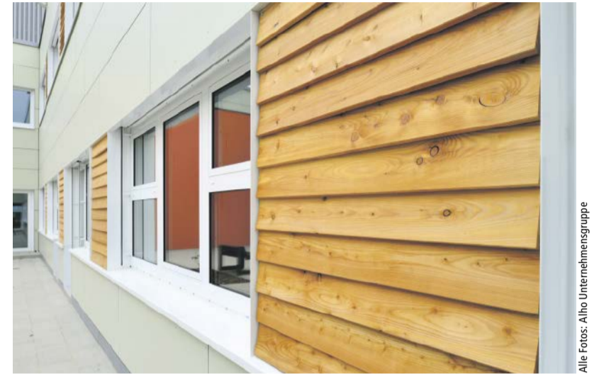
Der Einsatz unterschiedlichster Materialien macht eine individuelle Fassadengestaltung möglich, z.B. mit Putz auf Wärmdämmverbundsystem, Vorsatzmauerwerk oder vorgehängten, hinterlüfteten Fassadenelementen aus Metall, HPL, Faserzement oder Keramik.
