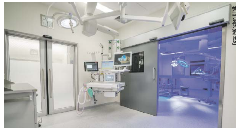
Der Neubau ist mit fünf hochmodernen OP-Sälen ausgestattet (+ ein Sectio-OP).
