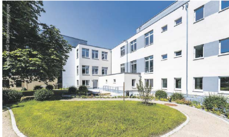
Am Städtischen Klinikum Braunschweig konnte die Alho-Modulbauweise einen ihrer größten (Nachhaltigkeits-)Vorteile ausspielen: Die Möglichkeit, bestehende Modulbauten abzubauen und an einen anderen Standort für eine Neunutzung umzusiedeln.
