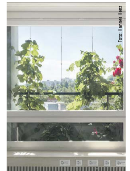
Die neue Fassadenbegrünung von Raderschallpartner AG Landschaftsarchitekten wirkt der starken Hitzeentwicklung im Gebäudeinneren entgegen.
