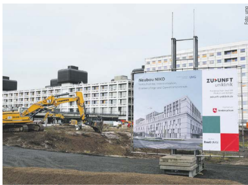
Im Dezember erfolgte der Startschuss, im Januar begannen die Arbeiten auf dem Baufeld vor dem Bettenhaus 1 der UMG. Die bauliche Fertigstellung ist für 2029 geplant und die klinische Inbetriebnahme durch die UMG bis 2030.
