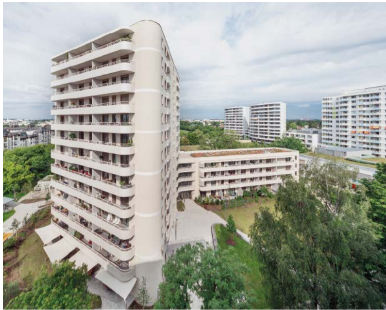
Das polygonale Wohnhochhaus und der zeilenförmige Baukörper der Augustinum Seniorenresidenz München-Neufriedenheim bilden ein harmonisches Ensemble.
