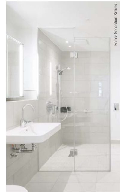
Komfort und Sicherheit beim Duschen: Die Thermostatarmatur beugt Verbrühungen vor, bei der Handbrause kann komfortabel zwischen den Strahlarten gewählt werden.
